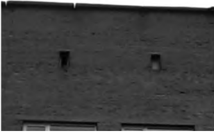
Рис.3. Вентиляционные отверстия чердака
